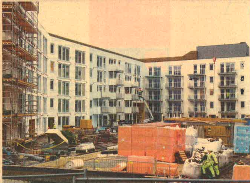
Ifølge Enova koster vannbåren varme i boligblokk cirka 200 kroner per kvadratmeter mer enn kostnaden for et komplett helelektrisk varmesystem. Her fra bygging av leiligheter i Ekebergportalen. Foto: Per Ståle Bugjerde
