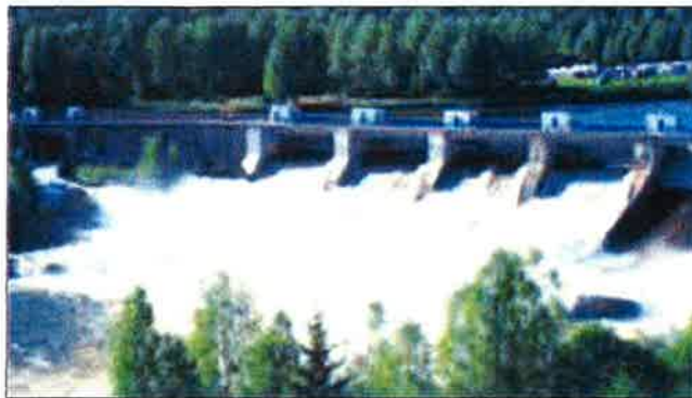
GRØNNVASKING: Norsk fornybar kraft blir ikke brukt i Norge, men legges ut på billigsalg, skriver innleggsforfatteren. Her fra Hunderfossen.
